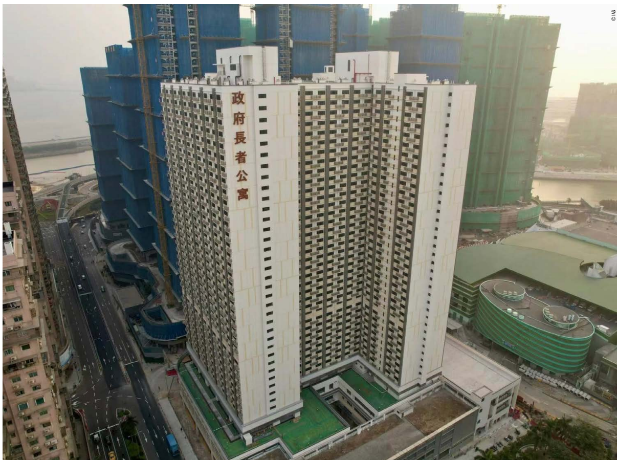
O complexo residencial é composto por duas torres de 37 andares
